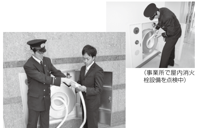
(事業所で従業員に対して屋内消火栓設備の取り扱い指導中)
